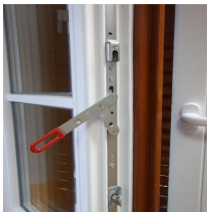
Slika 5 (Odprto pasivno krilo pri dvokrilnem oknu)
