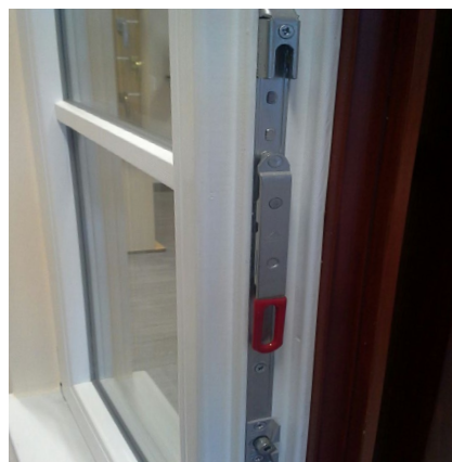
Slika 6 (Zaprto pasivno krilo pri dvokrilnem oknu)
